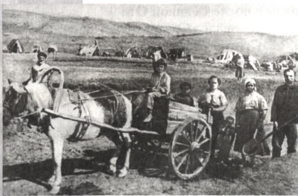
«Техника» на строительстве СУМЗа
