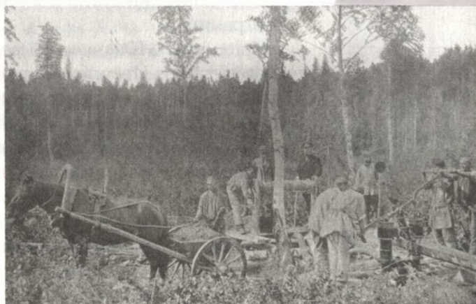
Пробивка шурфа на золотых приисках
