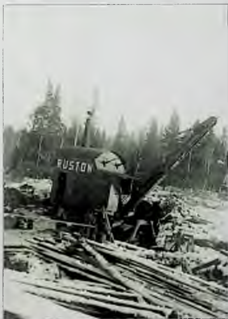
Строительство подъездного пути к шахте. 1934 г.
