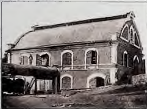
Заводской цех. Фото Соломирского
