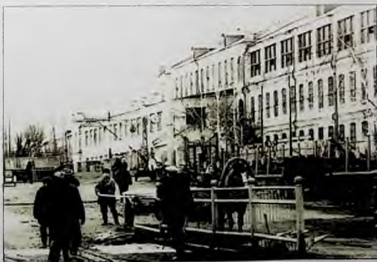
Ремонт плотины у Армильской суконной фабрики
