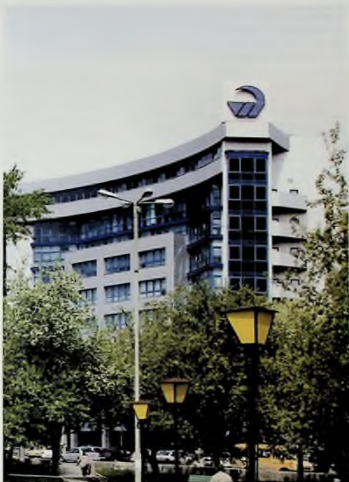
Здание, в котором смонтирована система Чиллер-фанкойл и приточно-вытяжная вентиляция
