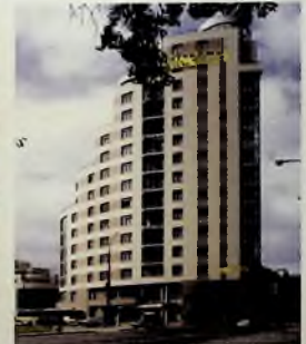
Жилой дом на ул. Никонова
