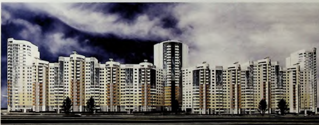
Многоэтажный жилой комплекс с нежилыми помещениями и подземным гаражом на ул. Плотников – Metallургов
