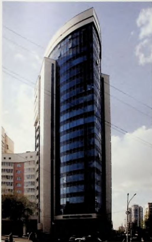
Здание, в котором смонтирована мультizonальная система кондиционирования VRV и приточно-вытяжная вентиляция
