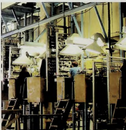
Монтажный участок цеха №1
