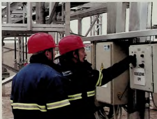
Включение новой подстанции в Пермском крае
