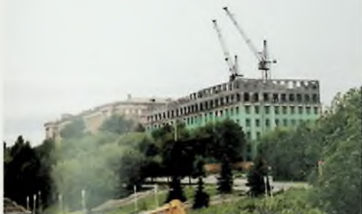
Строительство городских объектов
