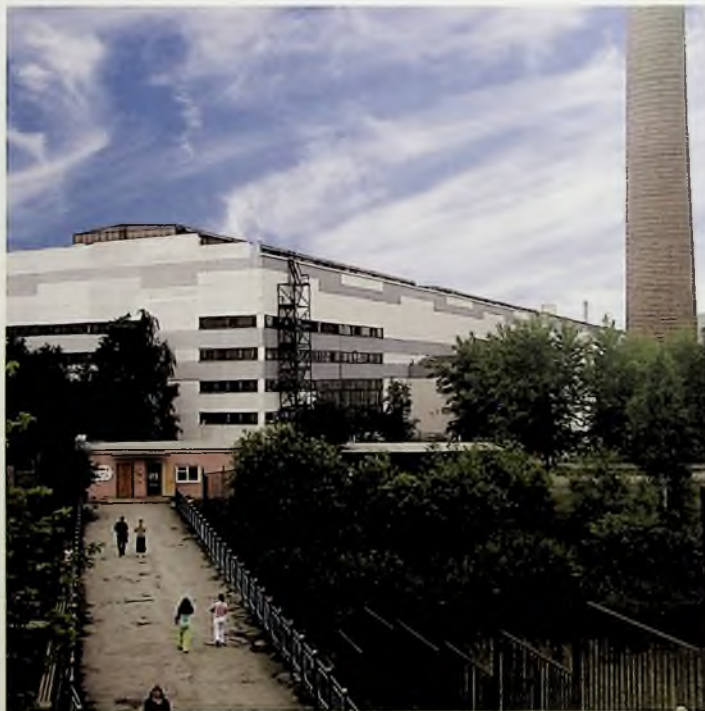
ОАО «Северский трубный завод»
