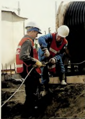
Монтаж кабеля 110 кВ
