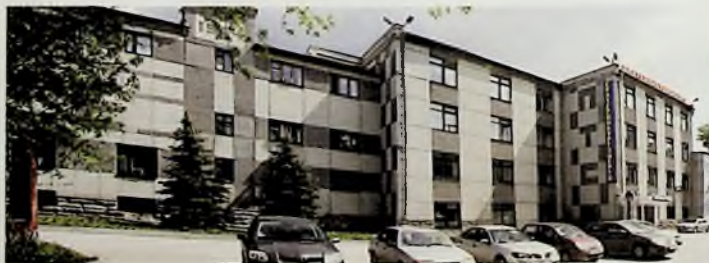
Административное здание «ЕКАТЕРИНБУРГЭНЕРГО»
