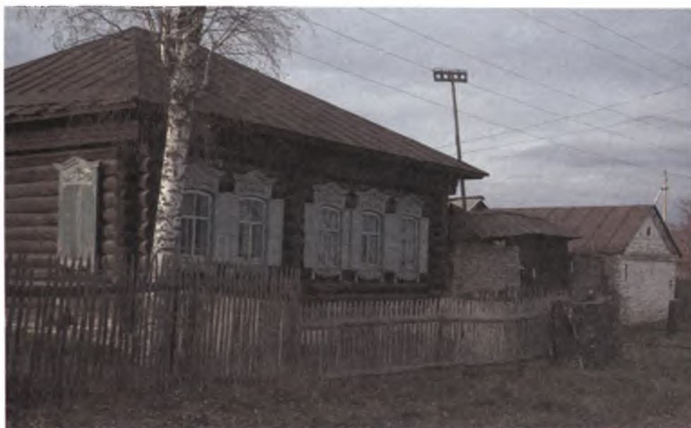
Четырехскатная крыша — признак зажиточности. Рядом с домом — хозяйственные постройки, деревянные или из плитняка.
