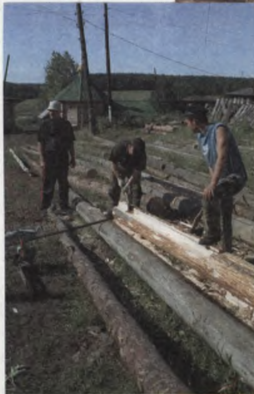
Обработка бревен для сруба. Изба долго стоит, если построена из прочного соснового леса, который растет на сухих местах. Такой лес «не потеет», как говорили в старину, а значит — не подвергается гниению.
