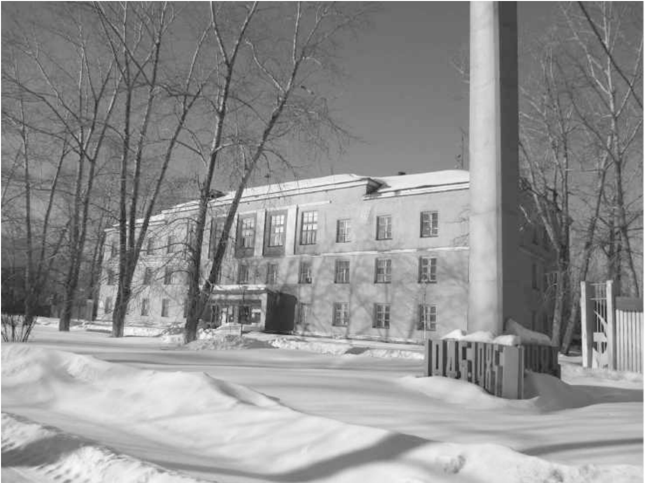
Управление Красноуральского химического завода
