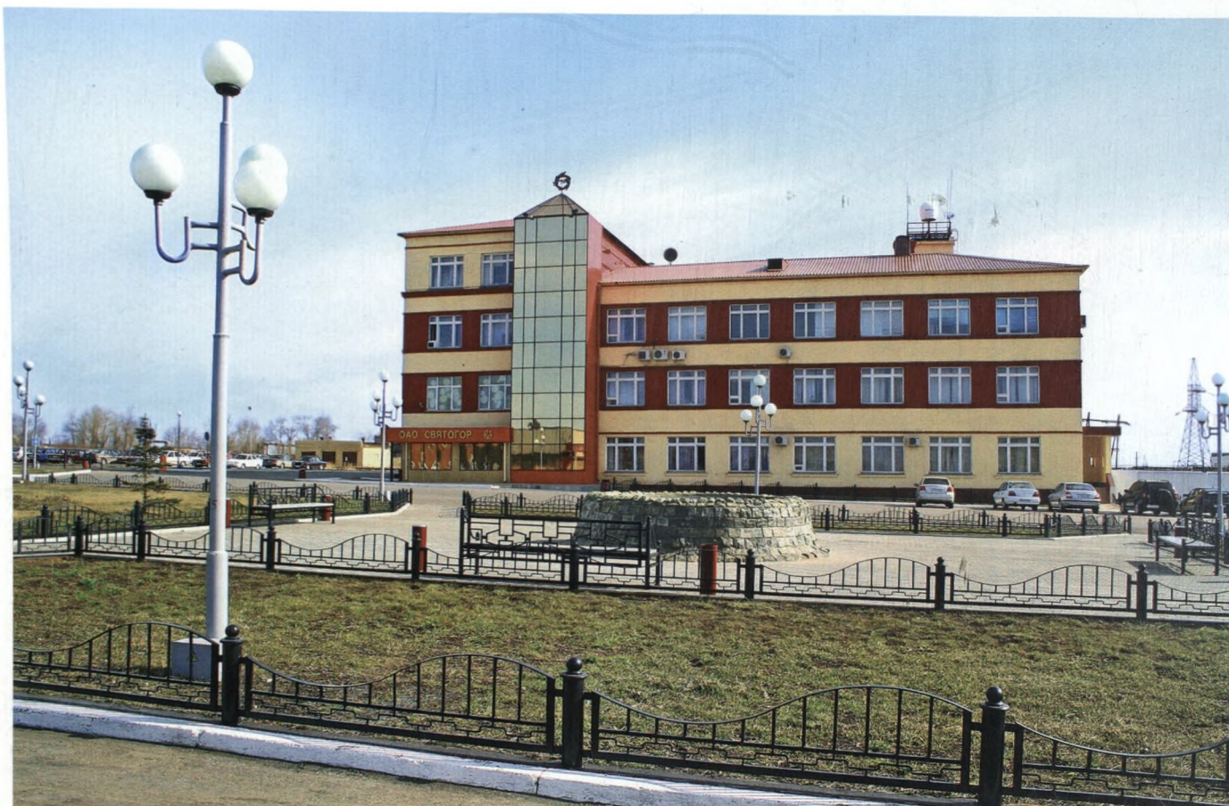
Здание управления ОАО «Святогор». 2006 год
