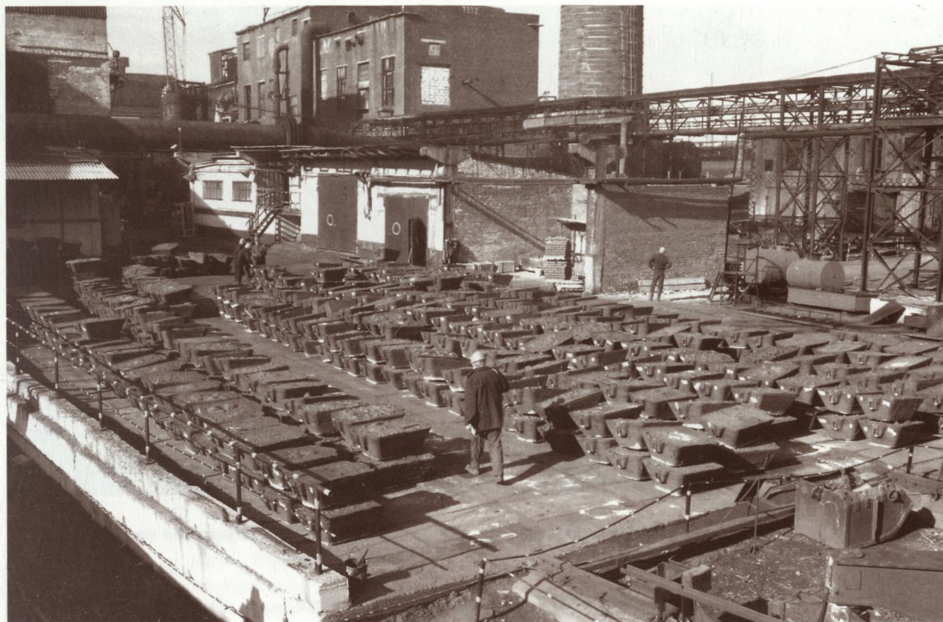
Площадка готовой продукции металлургического производства
