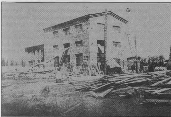
Строительство насосно-фильтровальной станции на территории завода. 1930 г.
