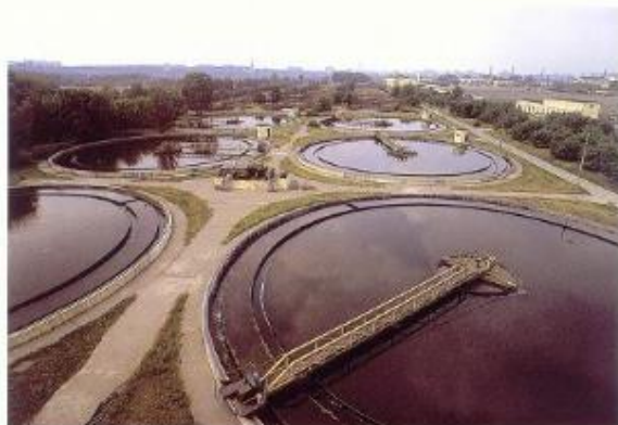
Курьинской станция аэрации — крупнейшее из многих очистительных сооружений Москвы. Здесь очищают все промышленные, так и бытовые стоки города
