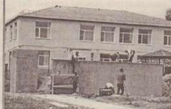
Ведутся строительные-монтажные работы по переносу памятника
