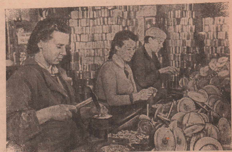
Стахановки двухсотницы монтировочного цеха сборщицы (слева направо) А. А. Григорьева, Ф. А. Крути и С. М. Чикина за сборкой противотанковых гранат.
