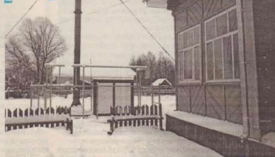
Новая автономная котельная в «Ленке».
