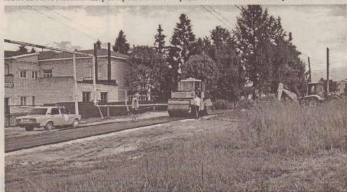
Укладка асфальта на ул. Сироткина.
