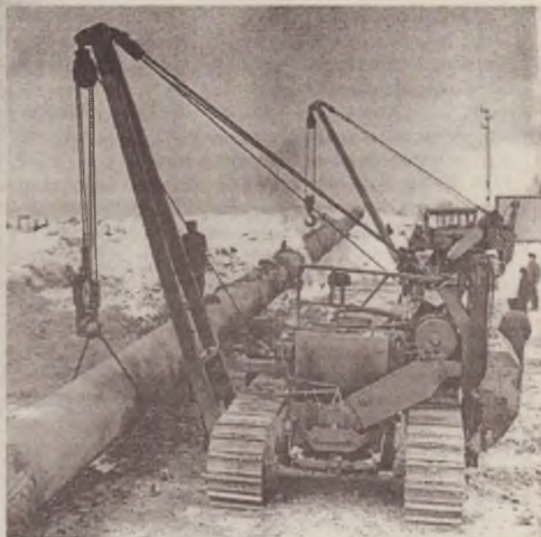
Прокладка дюкера (участка газовой трубы) через р. Узола.
