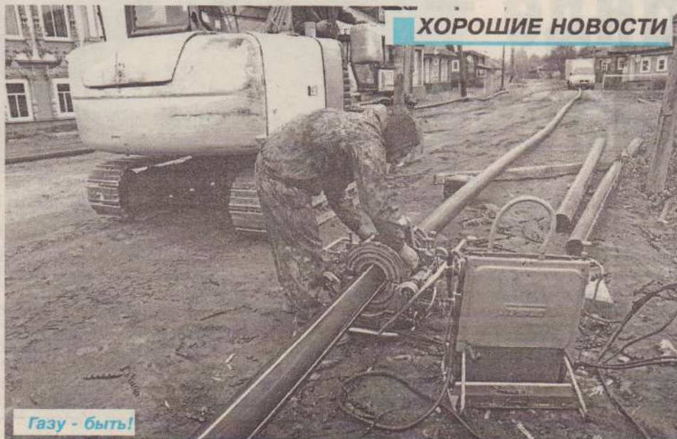
Монтаж выходов из земли непосредственно у дома.
