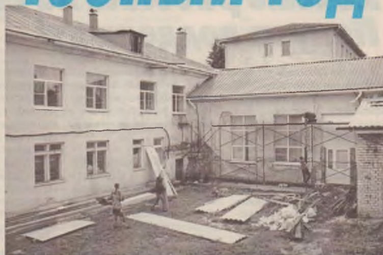
Идёт ремонт крыши здания Районного центра внешкольной работы.
