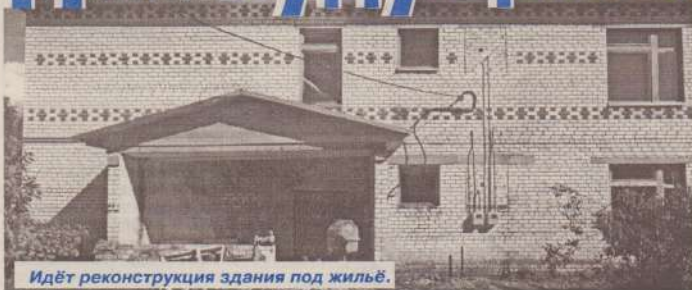
Идёт реконструкция здания под жильё.
