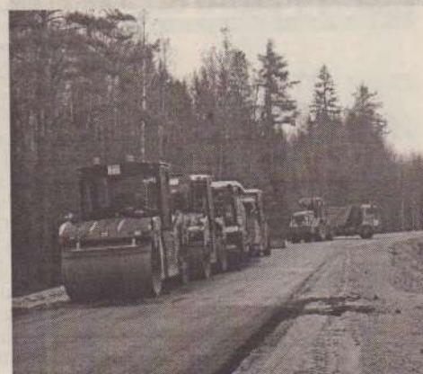
Завершена укладка верхнего слоя асфальта.
