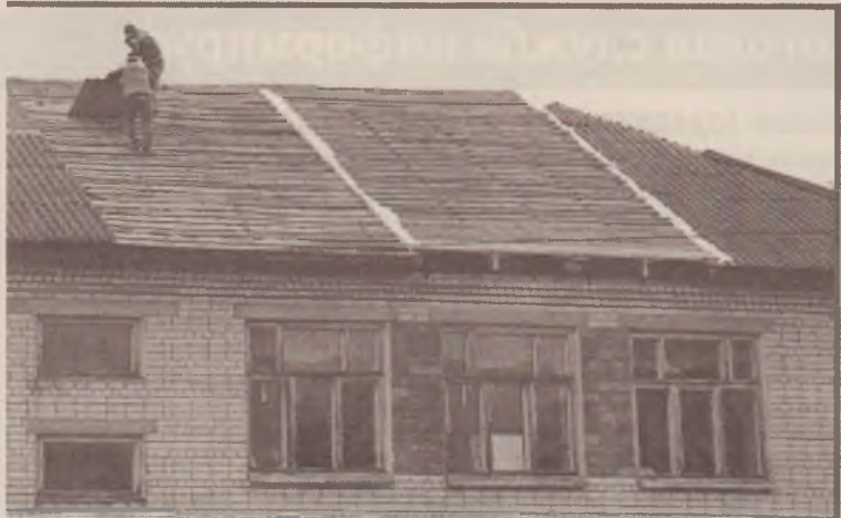
● Выполняется ремонт крыши детского сада «Светлячок».
