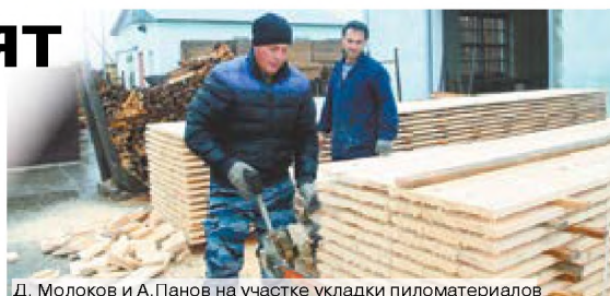
Д. Молоков и А. Панов на участке укладки пиломатериалов
