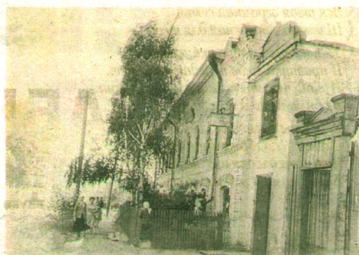
▲ Здание аптеки на ул. Бр. Смольниковых
