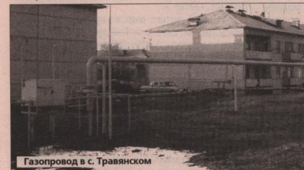
Газопровод в с. Травянском
