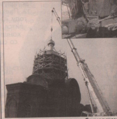
Восстановление церкви в с. Sosновском
