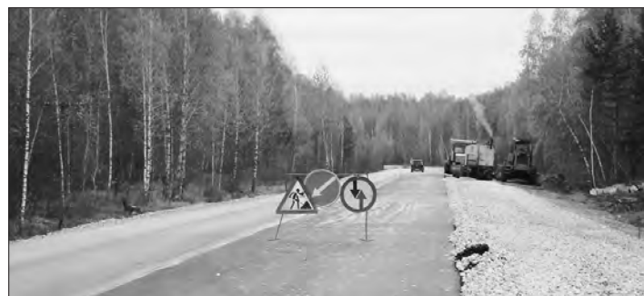
В 2019 г. в Каменском районе будет отремонтировано более 11 тысяч кв. м дорог и тротуаров
