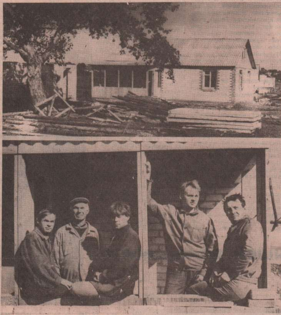
На снимках: один из новых домов; бригада строителей (слева направо): плотник А. Н. Мухрамов, печник П. И. Пичкар, штукатур А. М. Степанов, плотник С. Д. Селюнин, каменщик В. Н. Нестеров.
