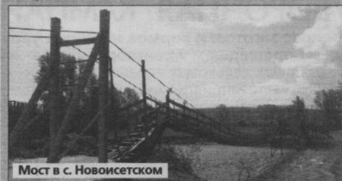
Мост в с. Новоисетском
