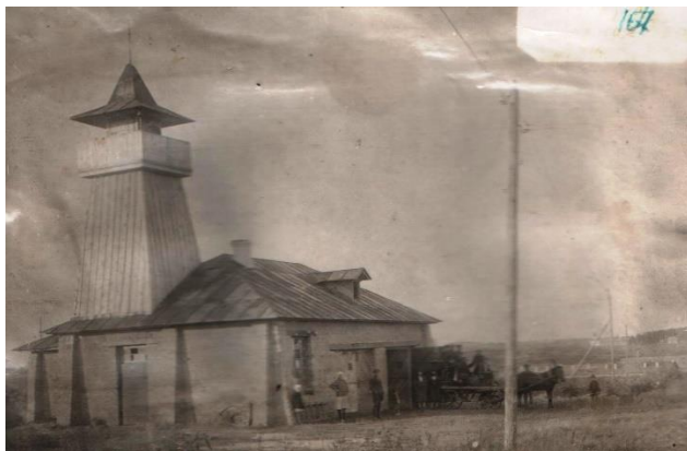
1934 г. Пожарное депо
