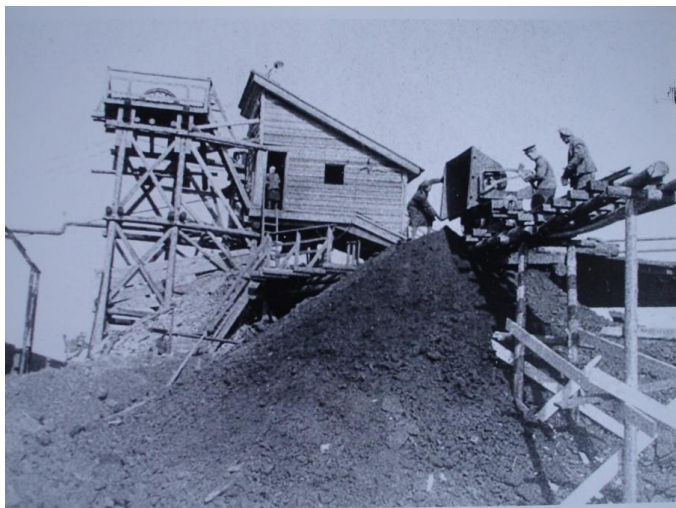
Наклонная шахта на СУБРе
