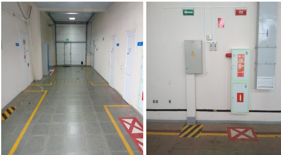
Рисунок 19 Визуализация опасных зон производственных помещений
