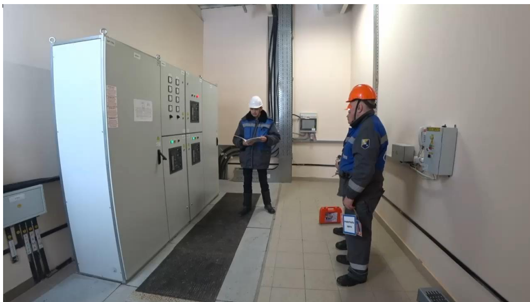
Рисунок 22 Видеофиксация допуска персонала к работам в электроустановках
