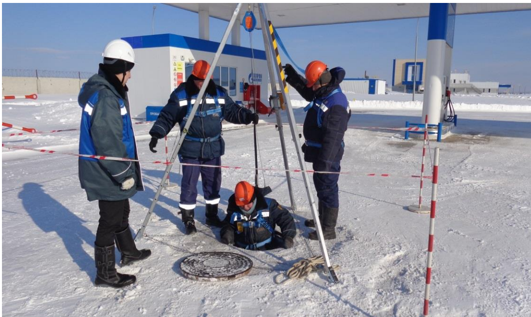
Рисунок 23 Работа в колодцах с применением штатива «Трипод
