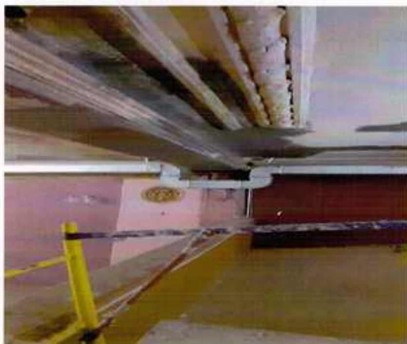
Фото 8 зашпатлеваны дефекты потолка балкона
