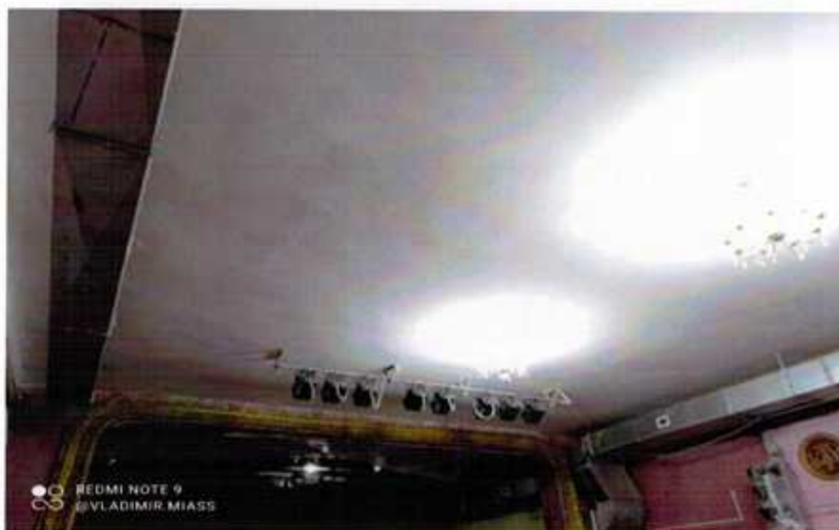
Фото 10 вид потолка зала
