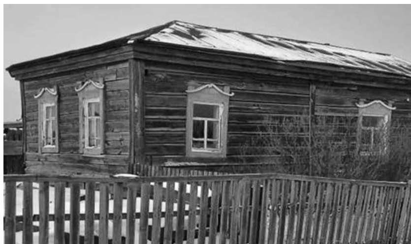
Рис. 4. Усадьба Сокуровых. «Людская»-кухня. Здание находилось на территории усадьбы. Фото Е. А. Корницкой, 2024 г.
