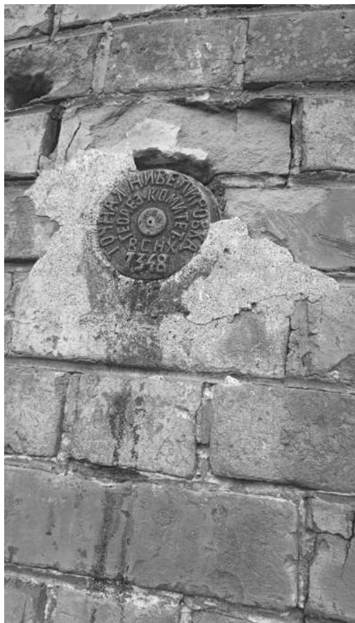
Рис. 2. Кладка водонапорной башни и геодезический репер. Село Троицкое, Троицкий р-н. Из личного архива Е. В. Семеняко.
