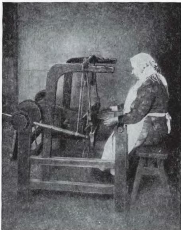
Илл. 83. Ткацкий стан с понебником, отделенным от задней рамы. Петроградская губерния (Фото Государственного музея этнографии народов СССР).
