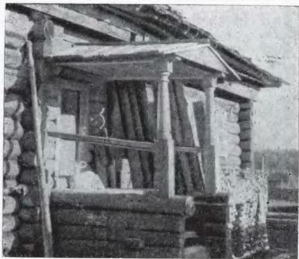
Илл. 108. Крыльцо срубное с двускатным покрытием. Деревня Верхборовская Соликамского района Пермской области. Конец XIX века.
