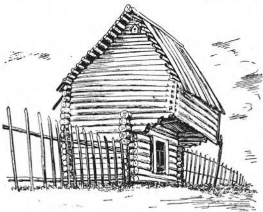
Рис. 546. Двухэтажный амбар с повалом. Деревня Емельяниха Городецкого района Горьковской области, начало XIX века. Рисунок С. К. Провсиркиной (Государственный Исторический музей).
