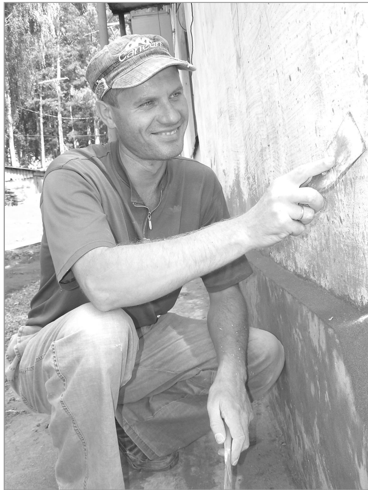
Штукатур Игорь Фролов в ООО «Стройэра» ценится за аккуратность в работе.
