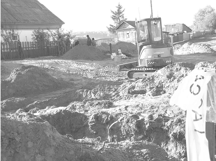
Для ускорения строительства объекта ГРП-22 в райцентре прокладку газопровода ведут две организации: ООО «Барнаул- газспецстрой» и ООО «Алт-Сервис». Фото Владимира КОНЮХОВА.
