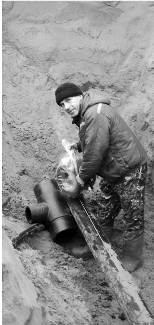
Сварку муфт на газовых сетях ведет Руслан Васильевич Павлов, сварщик «ГТМ-Строй». По его словам, все необходимые для строительства материалы есть.
