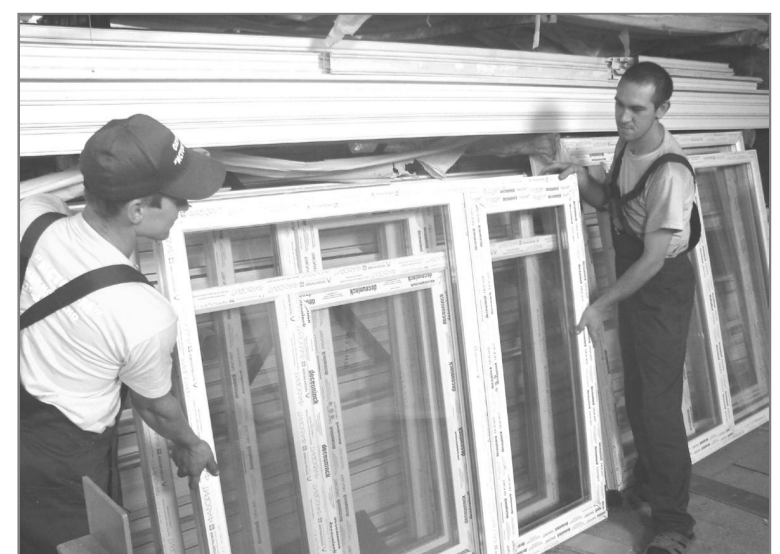
Окно готово к монтажу.
