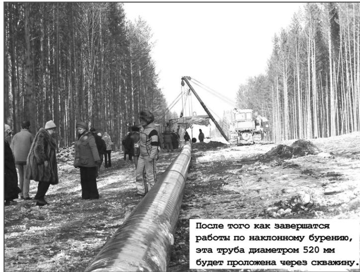
**После того как завершатся работы по наклонному бурению, эта труба диаметром 520 мм будет проложена через скважину.**
