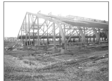
Строительство животноводческого комплекса идет полным ходом.
