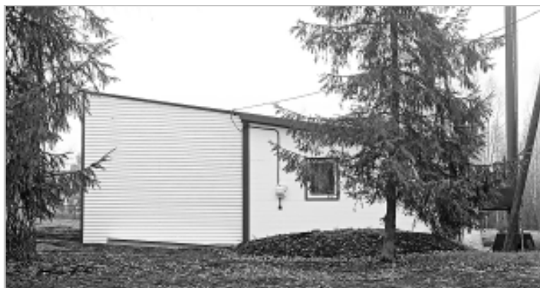
Здание котельной Новоеловской школы.
