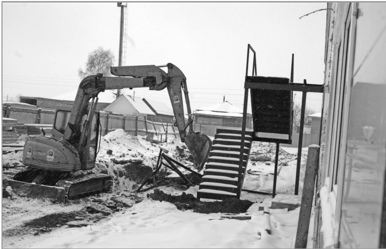
Работы на объекте, который возводится по губернаторской программе «80х80», еще много.
