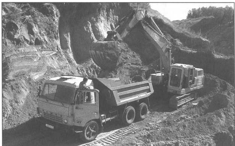
На строительстве дороги Тюмень–Беловский, 2002 г.
