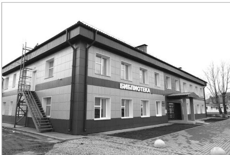
Недавно отремонтированное здание алейской библиотеки.
