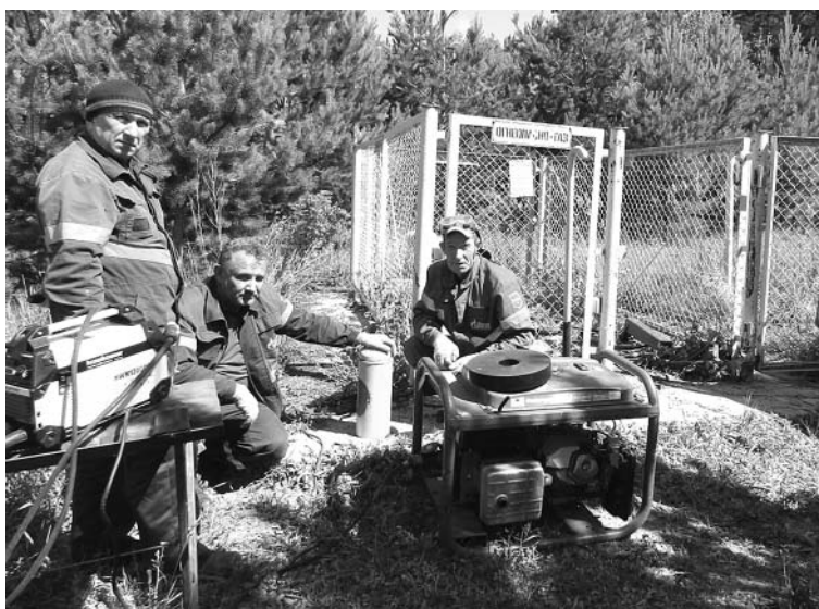
Электрогазосварщик Александр Витальевич Васильев, слесари газового хозяйства Алексей Иванович Брагин и Иван Николаевич Лаврентьев (на снимке слева направо) выполняют присоединение к межпоселковому газопроводу распределительных сетей в Заводском.
