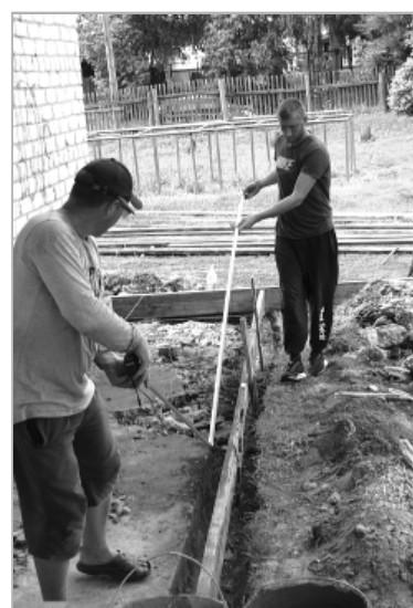
Чтобы приступить к обшивке стен металлом сайдингом, нужно восстановить отмостку.
