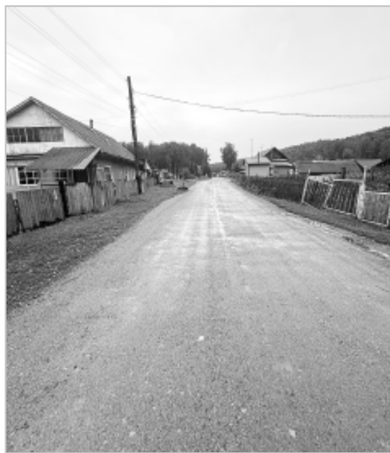
Отремонтированный, то есть отсыпанный щебнем, участок дороги протяженностью более 300 метров.
