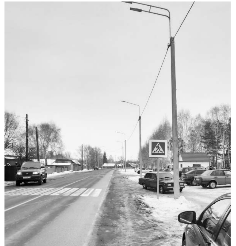
Линии наружного освещения в селе Троицком смонтировали по заказу КГКУ «Алтайавтодор» в соответствии со всеми требованиями. Эксплуатировать их будет филиал «Троицкий» Северо-Восточного ДСУ.
