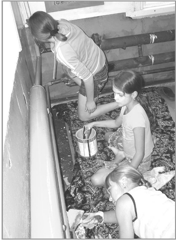
В СК «Баграм» АУ «Альтернатива» переделало систему отопления, воспитанники клуба красят батареи, приво-дят зал в порядок.
