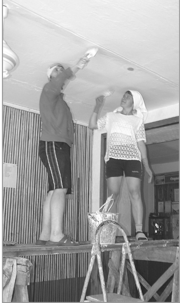
Косметический ремонт в Зеленополян-ской школе идет полным ходом.
