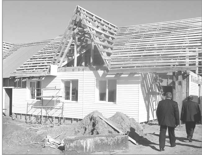
21 декабря прошлого года этот дом был сдан в эксплуатацию.
