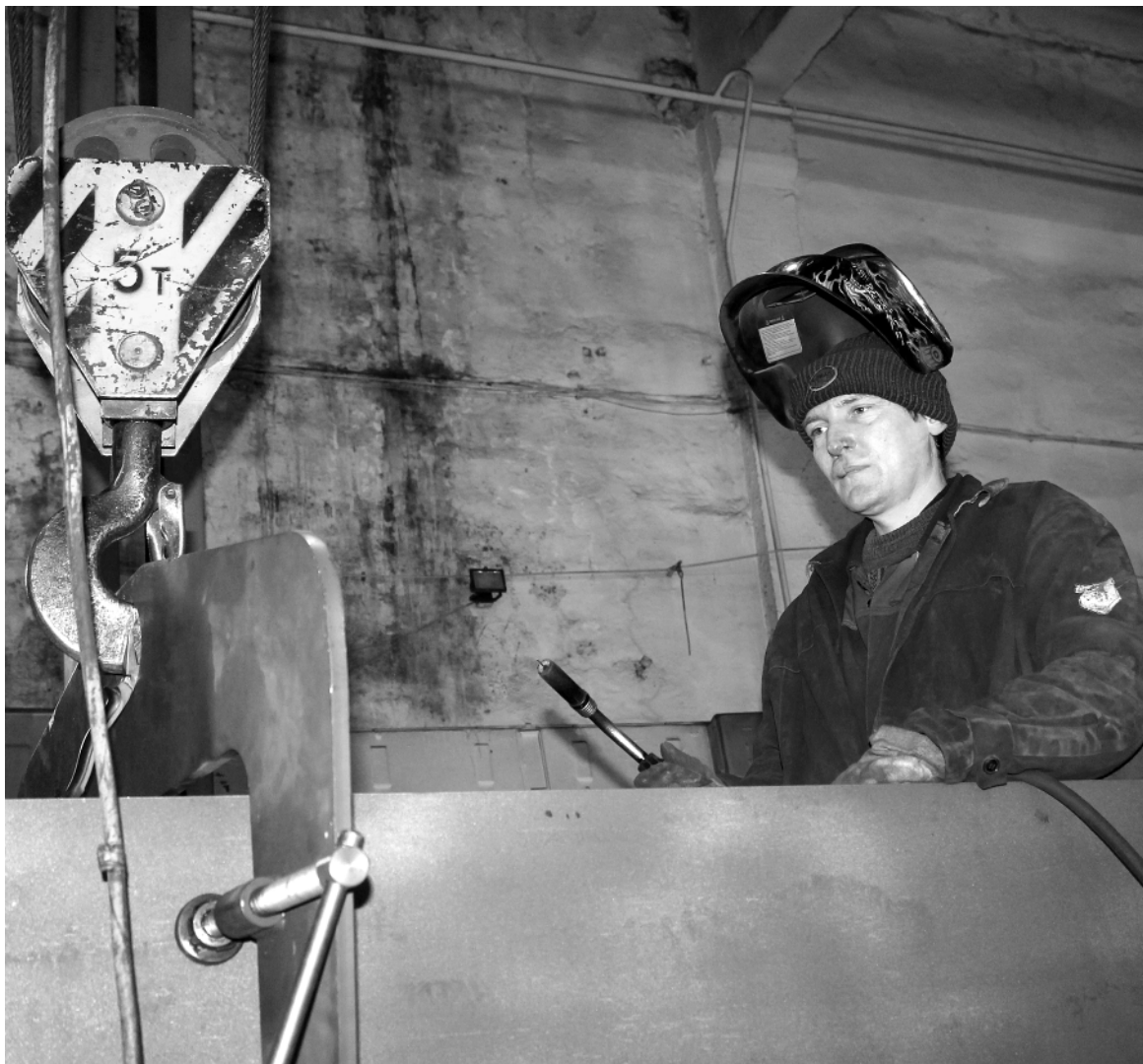
Газоэлектросварщик пятого разряда Александр Викторович Шушпанов трудится над изготовлением несущей балки мостового крана по заказу ООО «РусАтомЭкспертиза».
