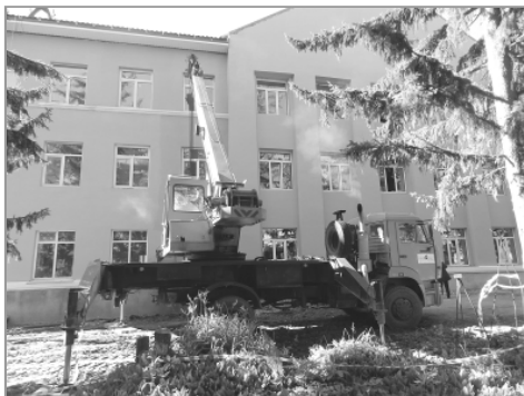
Наружная отделка здания Пролетарской школы уже подходит к концу, благодаря чему ее внешний вид заметно преобразился.
