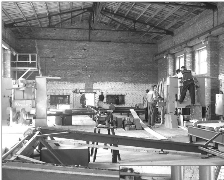
Монтаж оборудования завершен, но его надо «обкатать», устранить заводские недоделки. Этим и заняты работники, которым предстоит его эксплуатировать.
